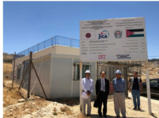
アインアルバアシャ地区で建設中の貯水施設
