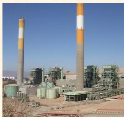
1994/1996年 アカバ火力発電所
